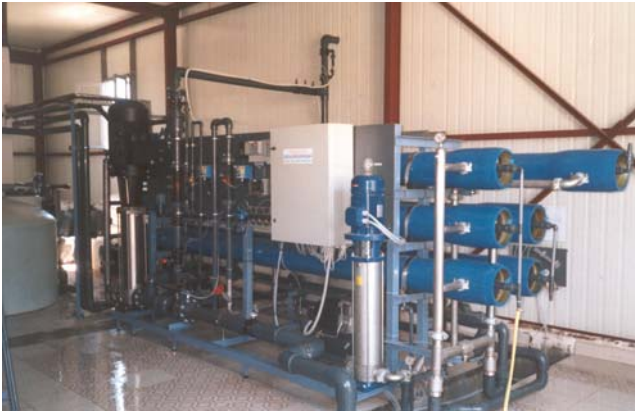
ΞΕΝΟΔΟΧΕΙΟ PORTO HYDRA ΗΜΕΡΗΣΙΑ ΠΑΡΑΓΩΓΗ: 700 m 3 ΠΟΙΟΤΗΤΑ ΝΕΡΟΥ ΕΙΣΟΔΟΥ: 4000 - 7000 ppm ΠΟΙΟΤΗΤΑ ΠΑΡΑΓΟΜΕΝΟΥ ΝΕΡΟΥ: ΠΟΣΙΜΟ ΙΟΥΝΙΟΣ 2001
