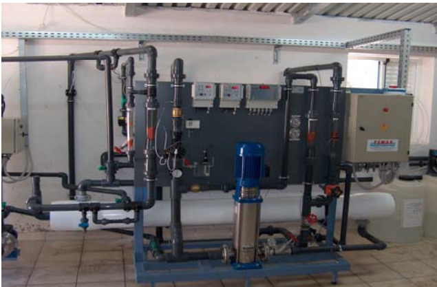
ΞΕΝΟΔΟΧΕΙΟ CARAVEL - ΖΑΚΥΝΘΟΣ ΗΜΕΡΗΣΙΑ ΠΑΡΑΓΩΓΗ: 80 m 3 ΠΟΙΟΤΗΤΑ ΝΕΡΟΥ ΕΙΣΟΔΟΥ: ΥΦΑΛΜΥΡΟ ΠΟΙΟΤΗΤΑ ΠΑΡΑΓΟΜΕΝΟΥ ΝΕΡΟΥ: ΠΟΣΙΜΟ ΜΑΪΟΣ 2005
